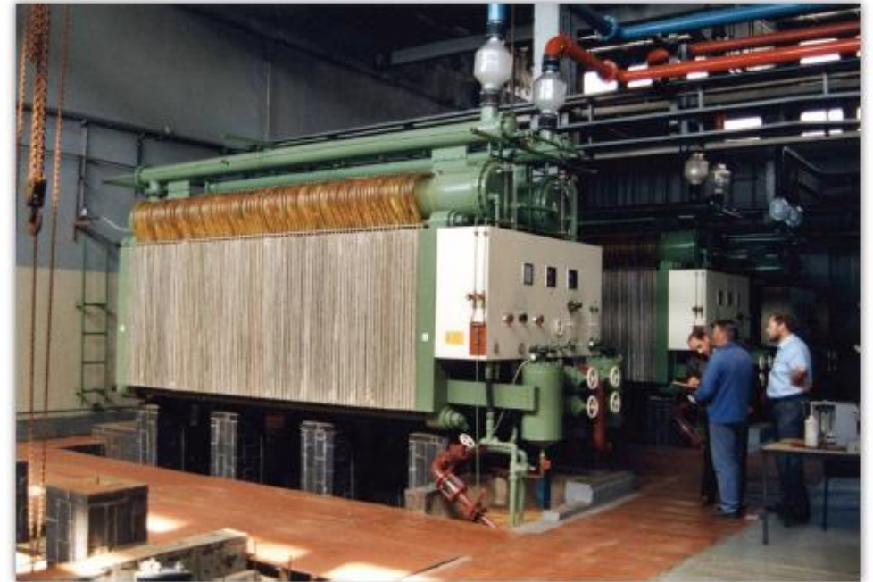
Aswan Electrolyser (KIMA) 165MW - 37000 m 3 H 2 /h
