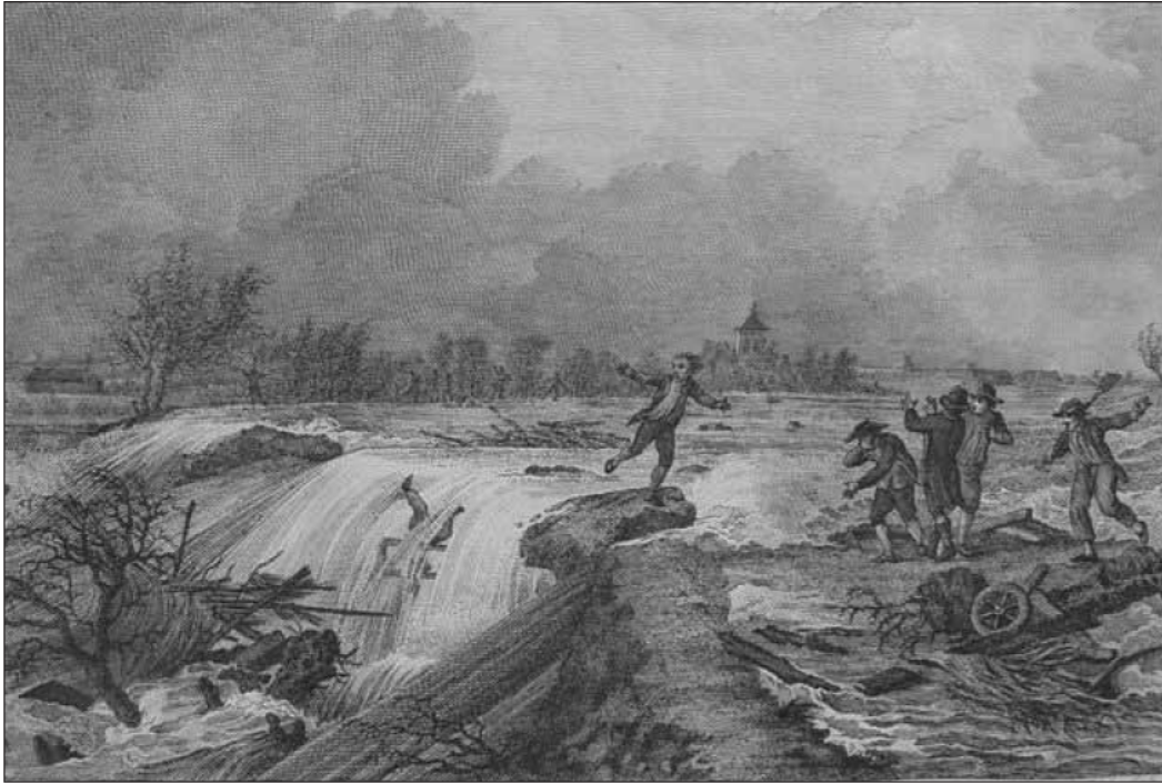
Figuur 15: Overstroming van de Linge bij Kedichem, 1809 (Reinier Vinkeles, 1809). Mede door deze dijkbreuk rukte de overstroming op tot aan de Kinderdijk [9].
