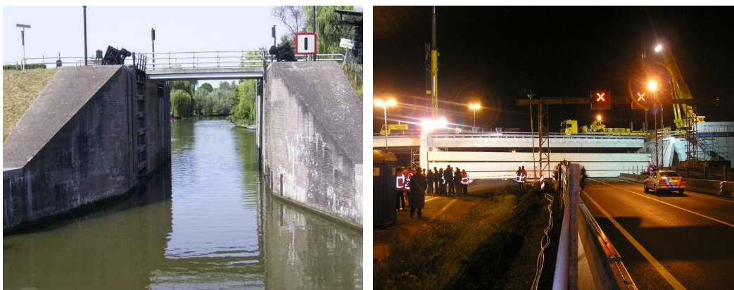
Figuur 67: Kunstwerken in de Diefdijk (links Zuidelijke Lingesluis, rechts coupure A2).
