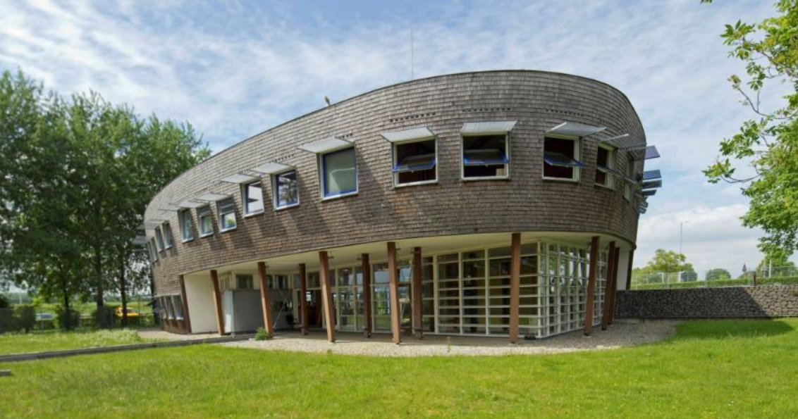
Districtskantoor Rijkswaterstaat Terneuzen
