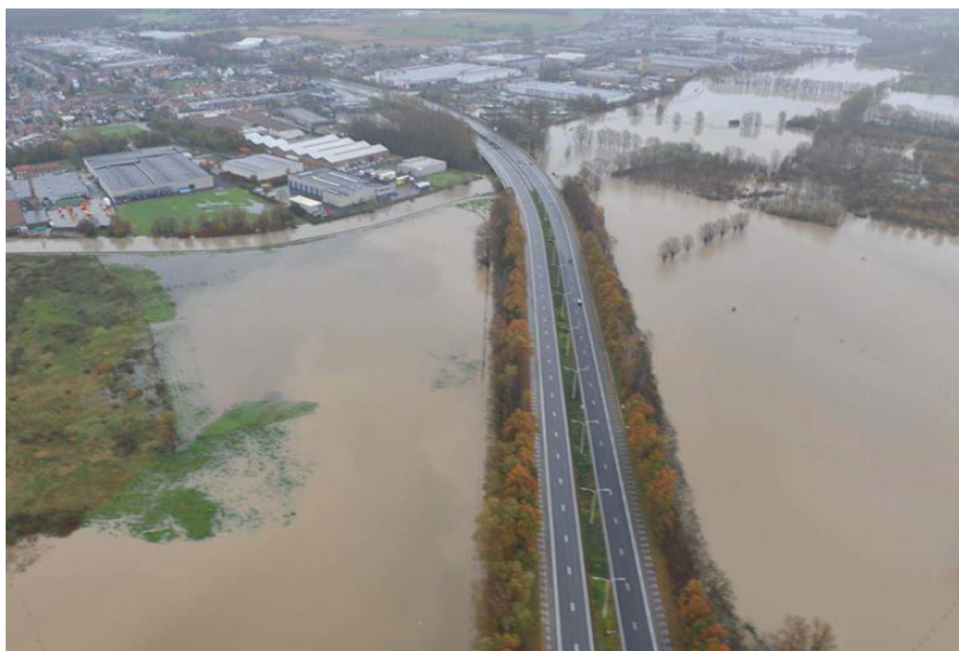
Overstroming van de Burchtdam in Ninove (foto: Marius Meremans)
