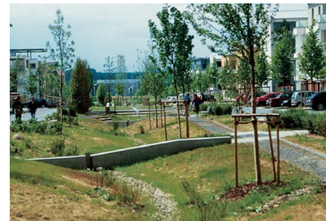
Waterbufferende en infiltrerende binnentuin in nieuwe ontwikkeling. Kronsberg, Hannover, Dreiseitl Atelier
