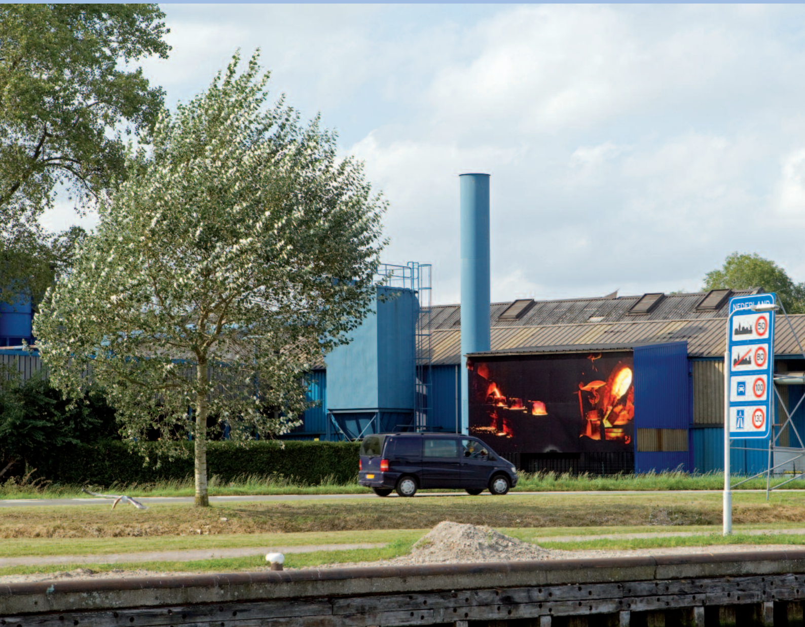
Op het gebouw van de Zeeuws-Vlaamse Gieterij is een grote afbeelding van het productieproces geplaatst.
