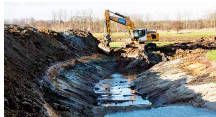
▲ Herstelwerkzaamheden hermeandering Essche Stroom
